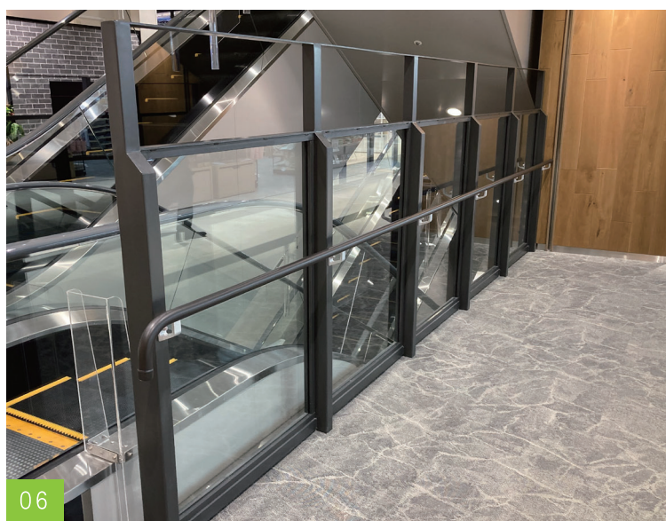
10. 外部階段蹴込板・手摺（溶融亜鉛めっき）
